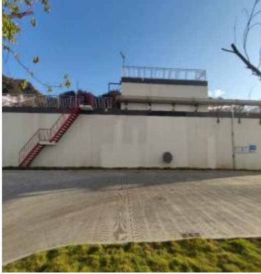
废水处置设施
