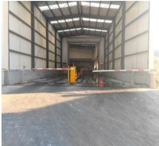
垃圾运输通道
